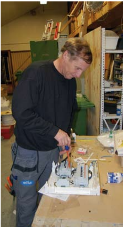
Gunnar Skoglund reparerar en elcentral.
