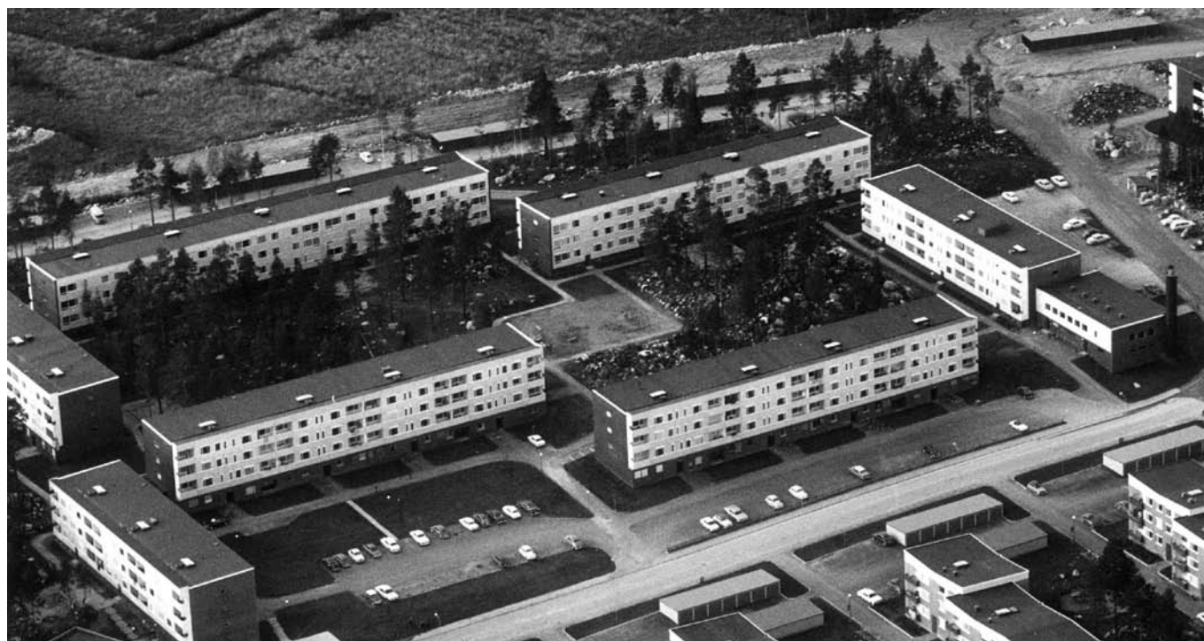
Flygfoto över den del av mossan som nu rivits.
