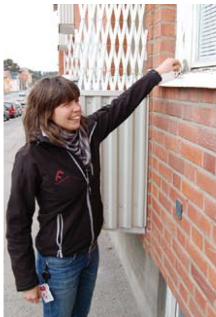
200 fönster ska renoveras.
